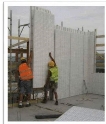
Fasi di montaggio pannello doppio portante e solaio Nidyon; vista edificio realizzato a Norcia.
